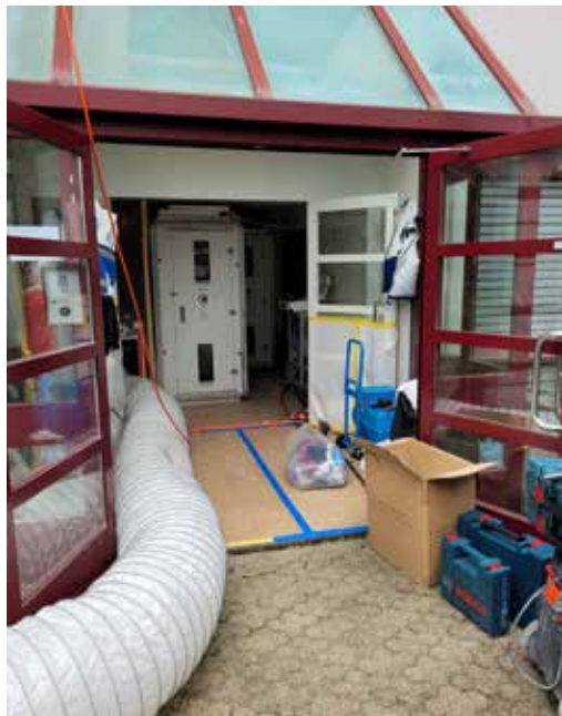
Asbestsanierung
